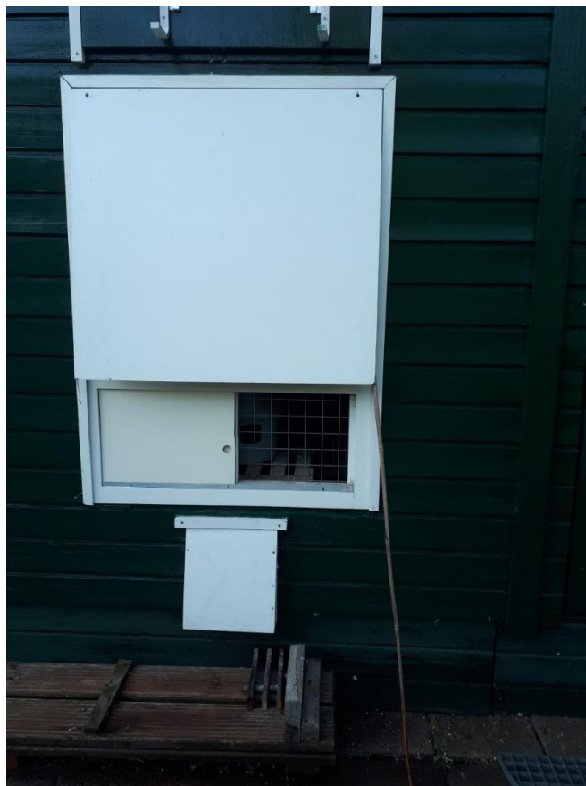
De verluchting voorzijde vlieghok op "avondstand"
